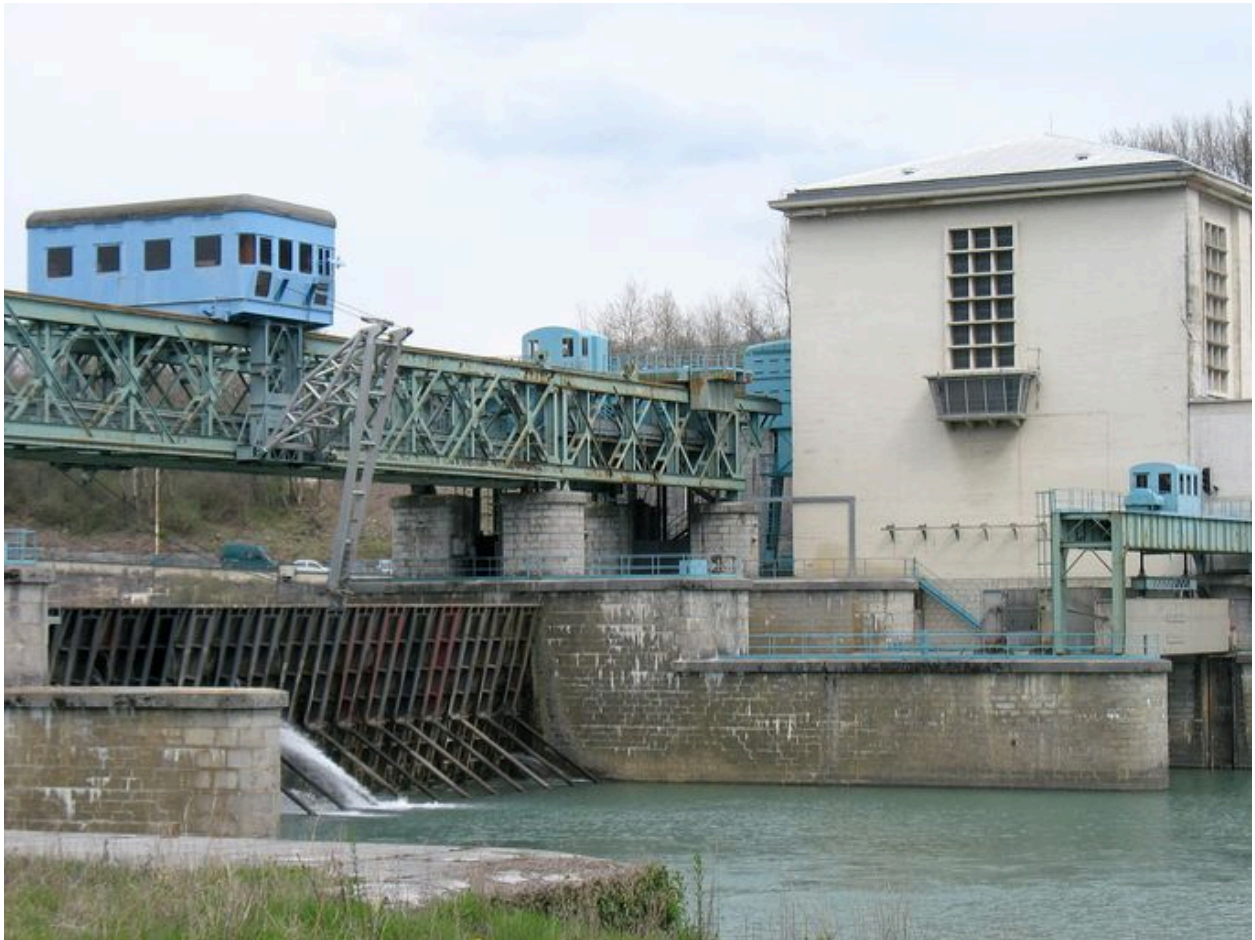
Vue partielle de l'usine-barrage, face aval (depuis l'ouest)
