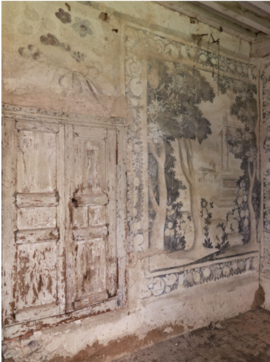
Vue du mur ouest.
