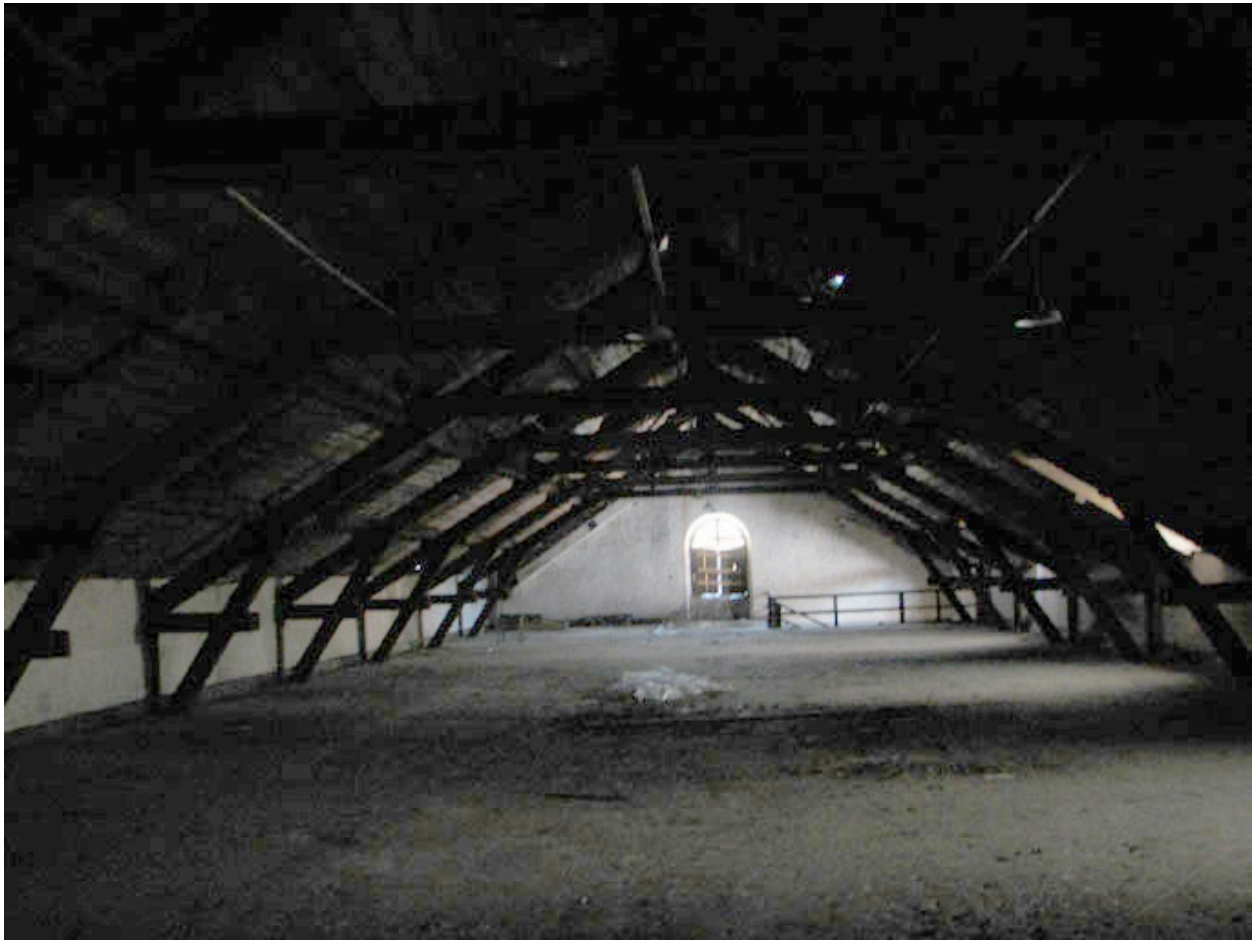
Etage de combe charpente en bois
