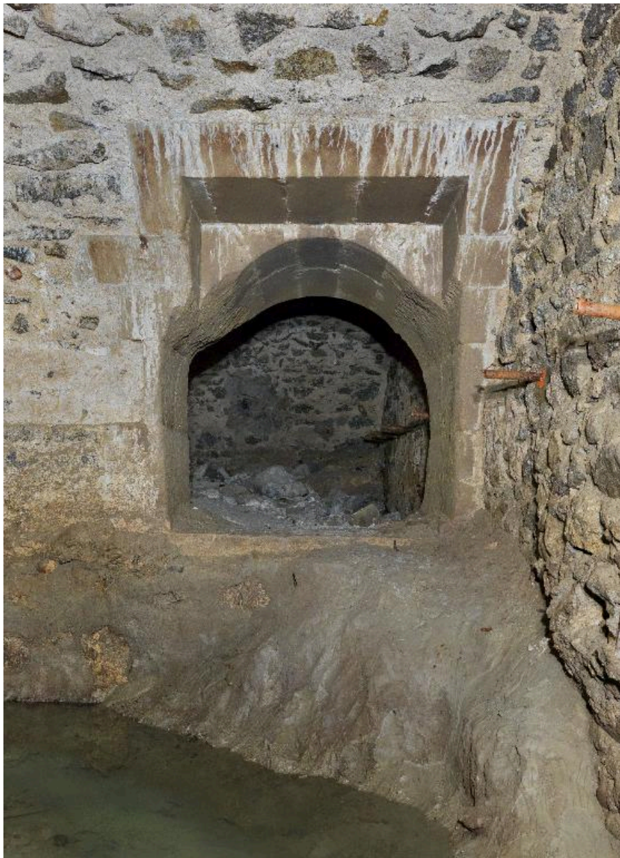
Bâtiment A, 16e siècle, sous-sol : détail de l'accès à la citerne
