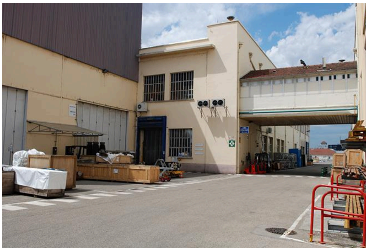
Vue des circulations aériennes : passerelle couverte
