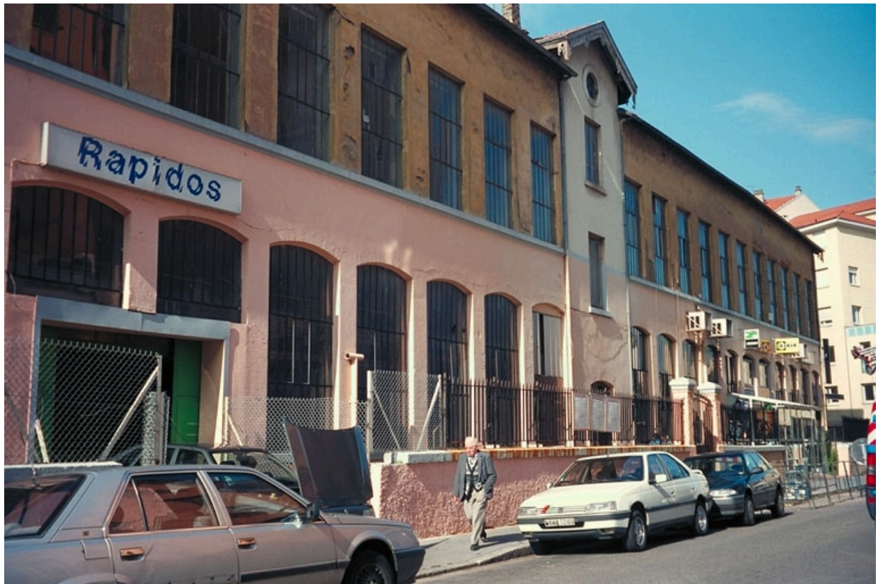
Vue d'ensemble nord-est
