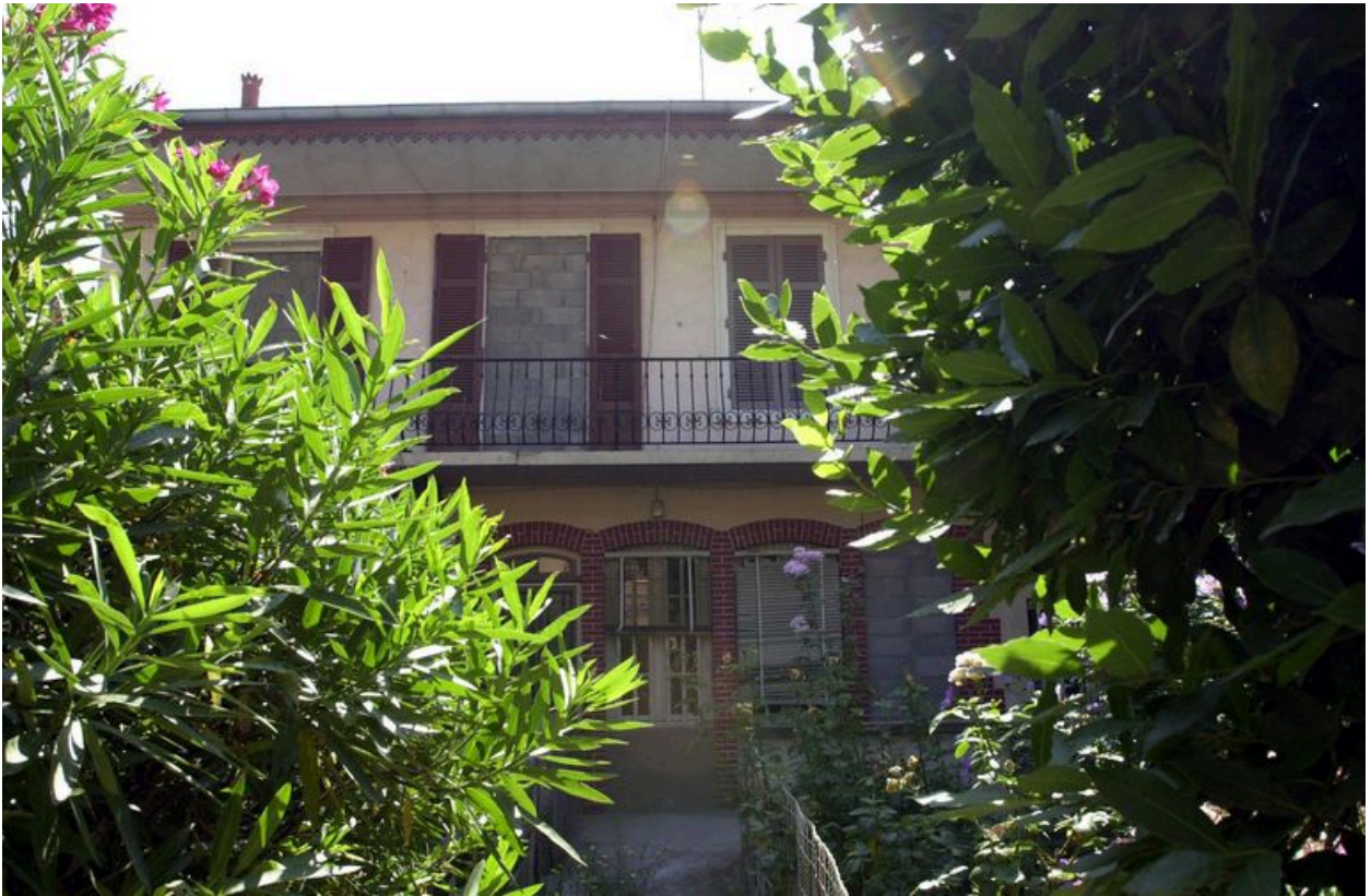
Élévation antérieure vue de face
