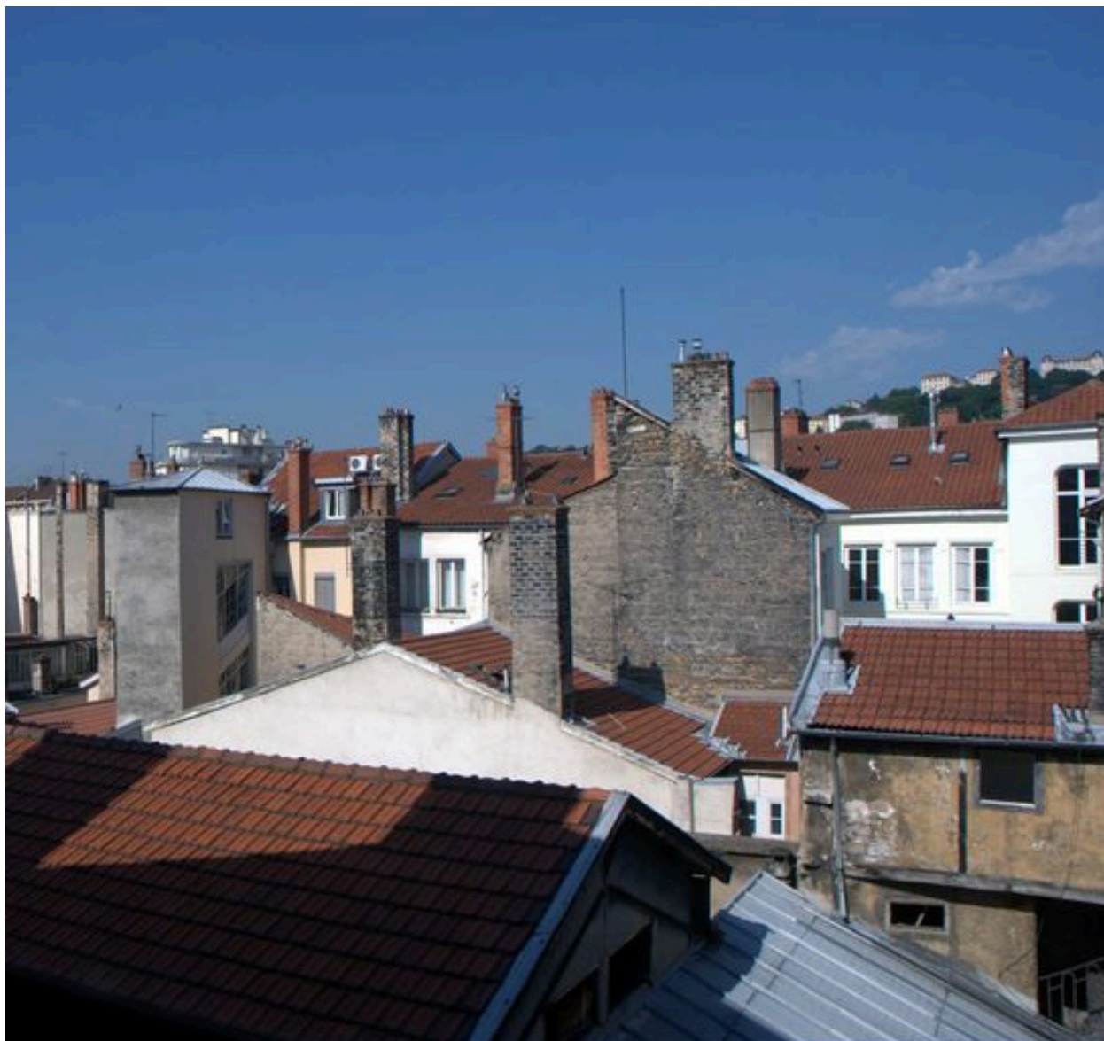
Vue de la partie nord-ouest du coeur de l'îlot, depuis le nord-est (26 rue Thomassin)
