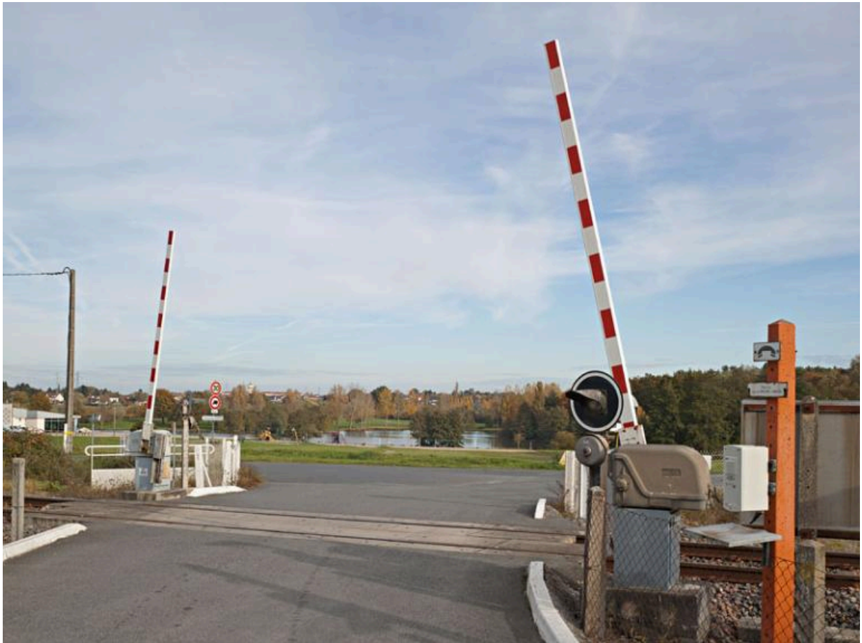
Vue du passage à niveau des Sapins, à proximité de la base de loisirs, au sud-est de Moulins.
