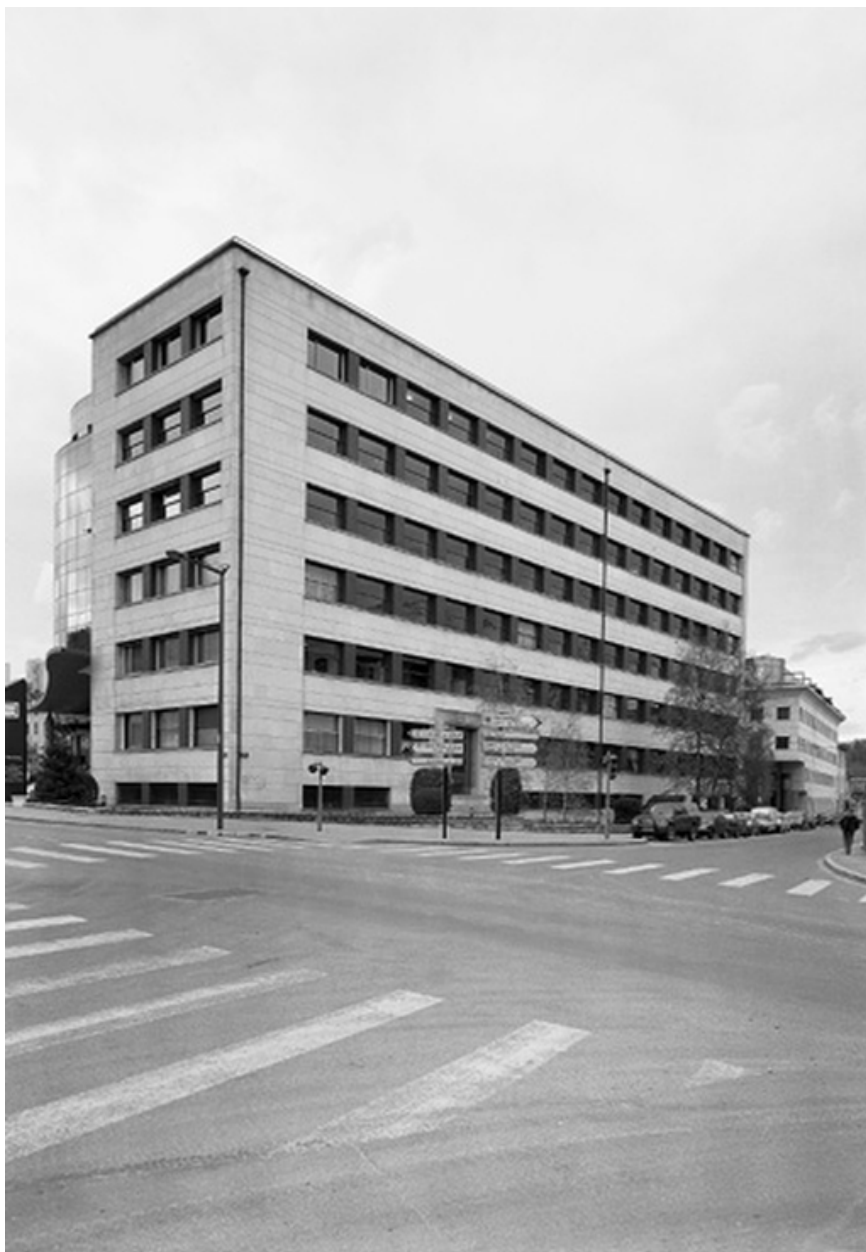
Vue de l'ancien bâtiment 'recherche' de la Rhodiacéta, actuellement occupé par le groupe Saci
