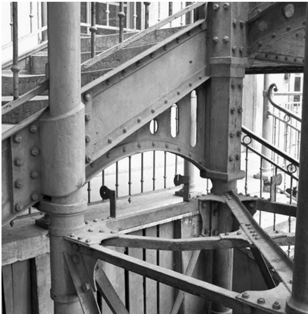
Ecole Ozanam, escalier hors-oeuvre de la cour : assemblages
