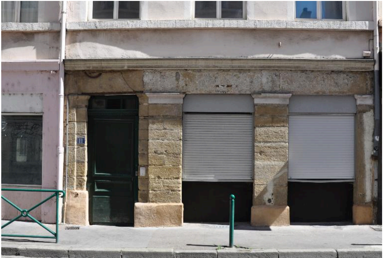
Vue rapprochée du rez-de-chaussée, piliers séparant les boutiques
