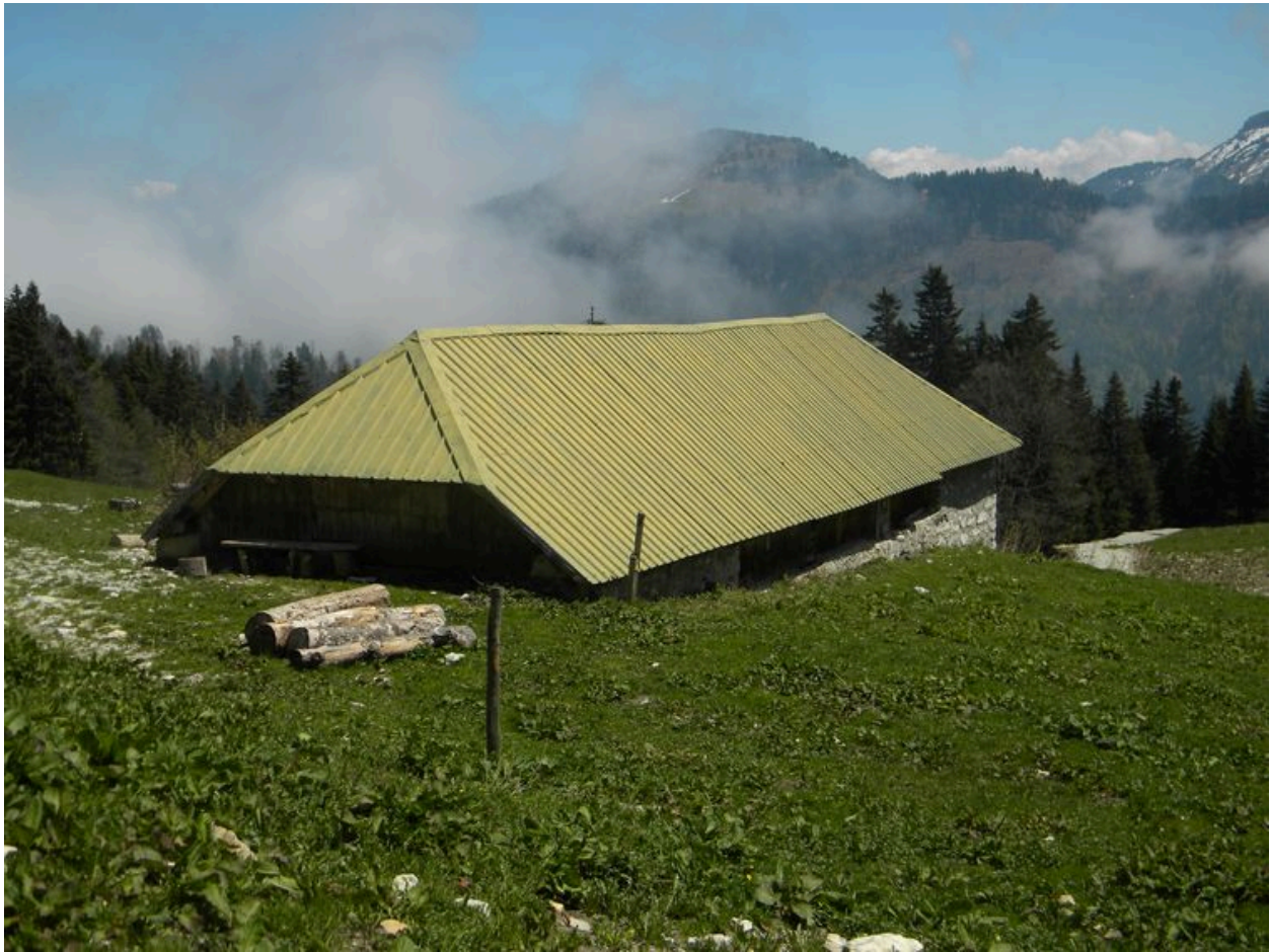
Vue de l'étable avec la façade sud.
