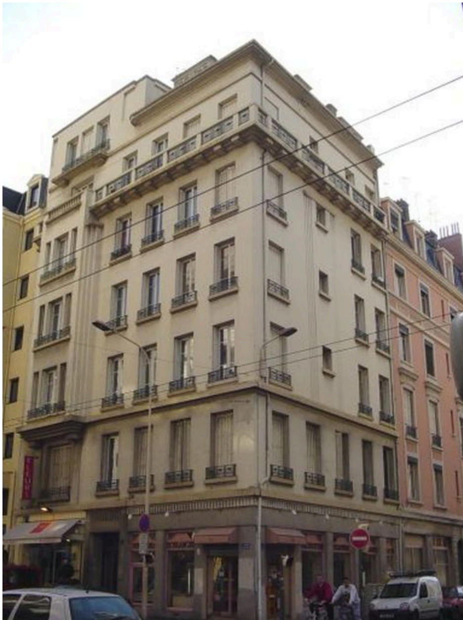
Vue générale de l'élévation
