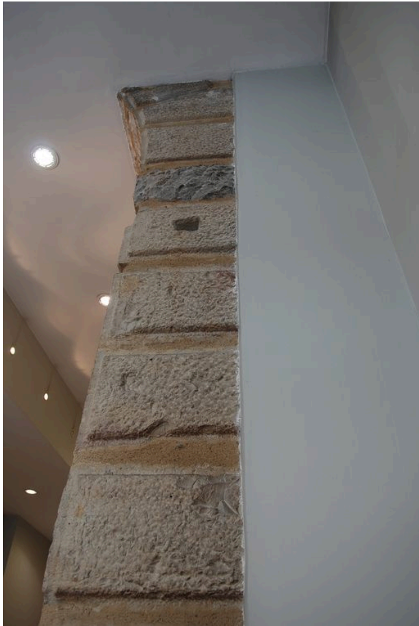
Intérieur ouest : pilier du XVIIe, encoche
