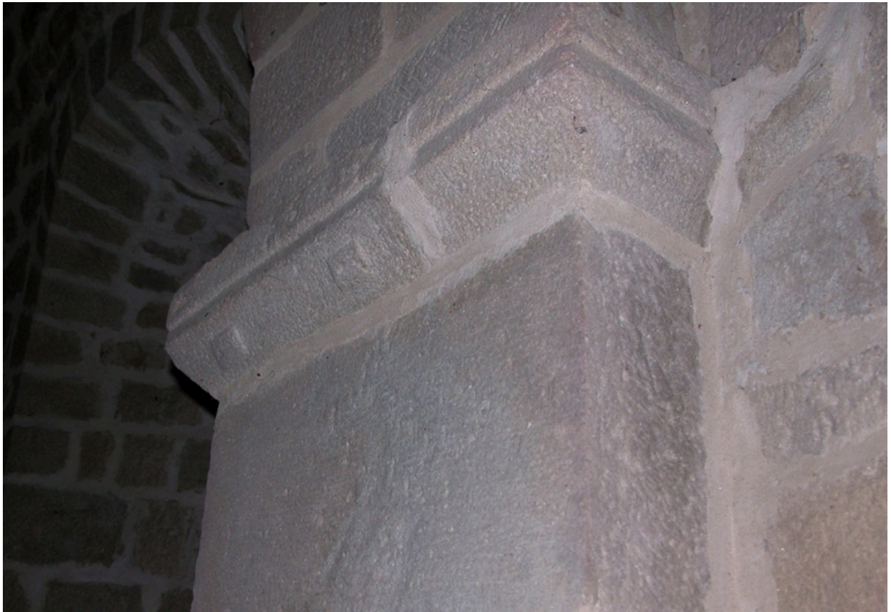
Détail de l'imposte du pilier nord du choeur (travée de choeur, angle nord-ouest).
