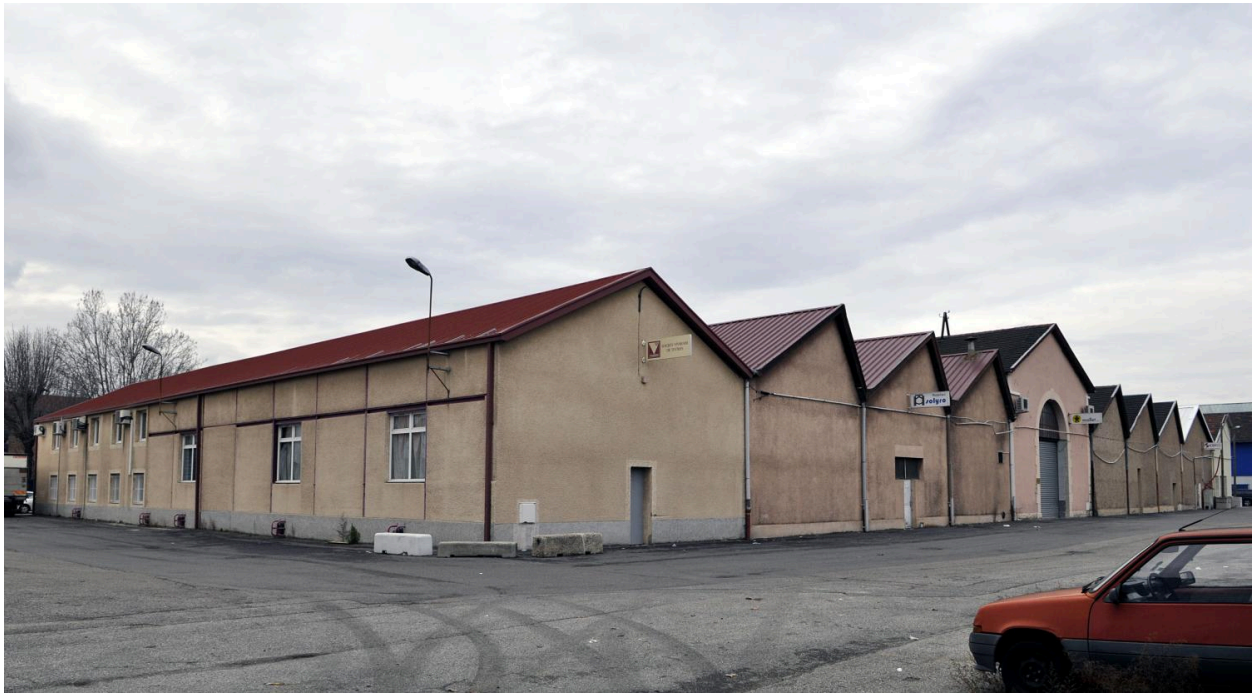
Vue d'ensemble des ateliers sur cour (dont la halle)
