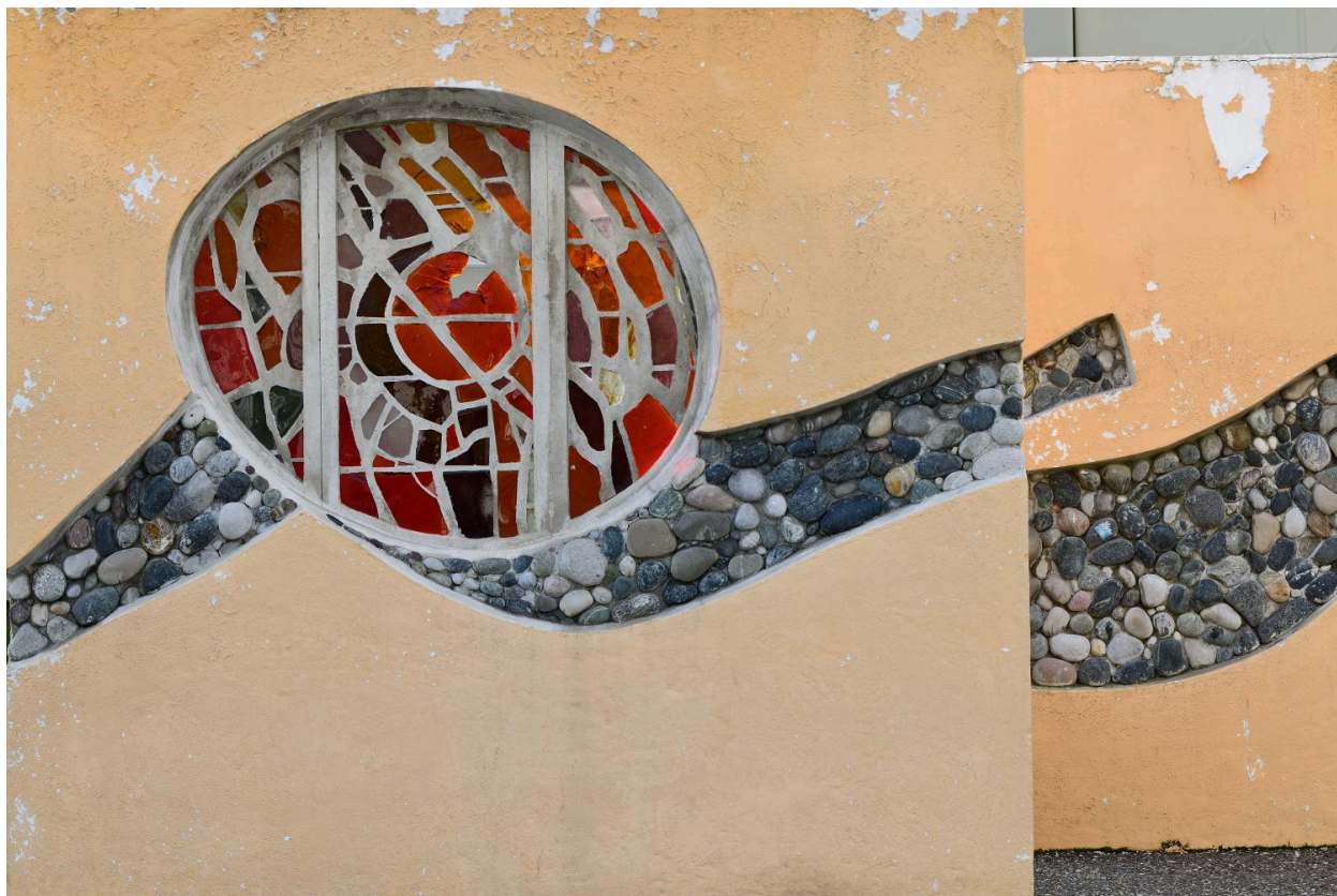
Première partie de l'installation, vue rapprochée d'un panneau.
