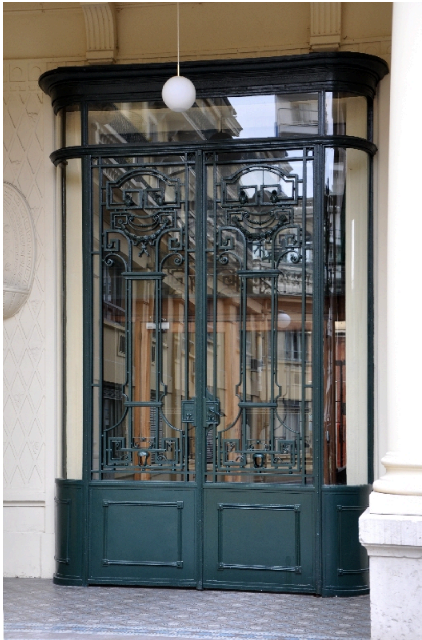
Porche ouest : détail de la porte sur cour
