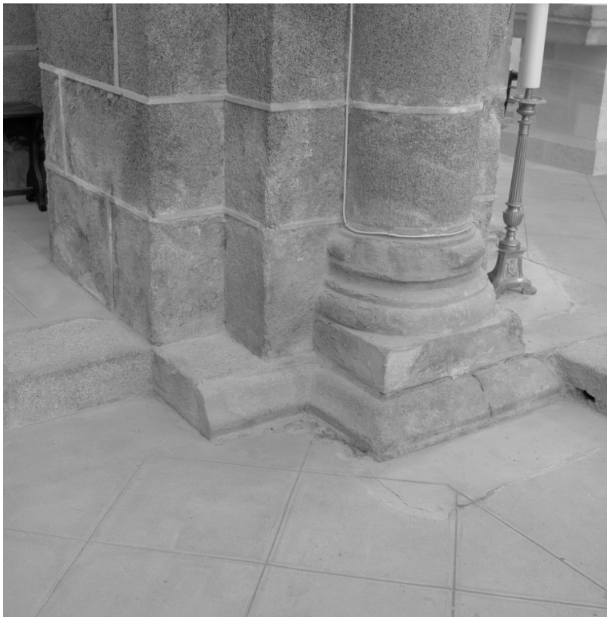
Base de la pile nord à l'entrée du chœur.
