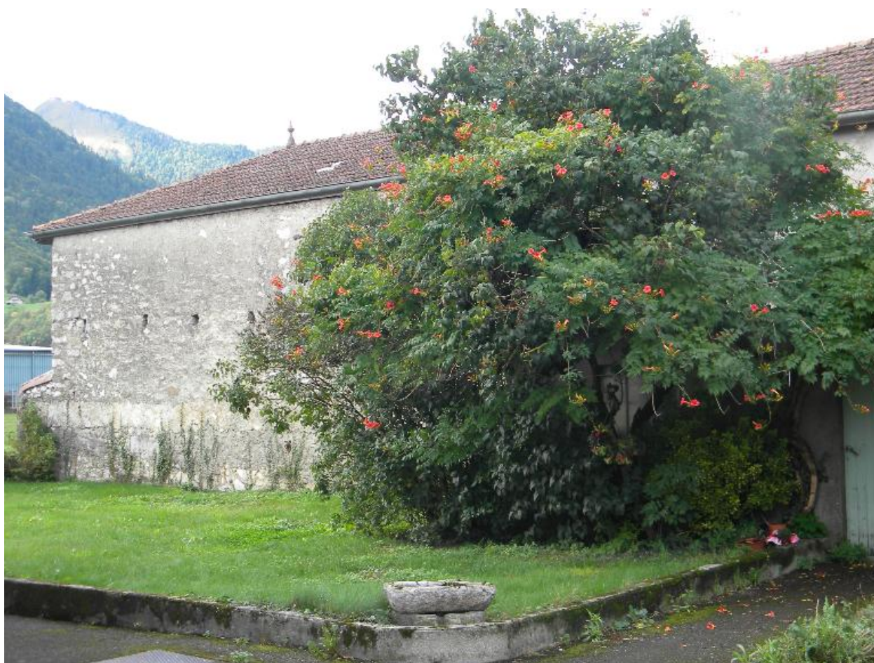
Façade est d'un ancien bâtiment fortement remanié (2008 C6 906)
