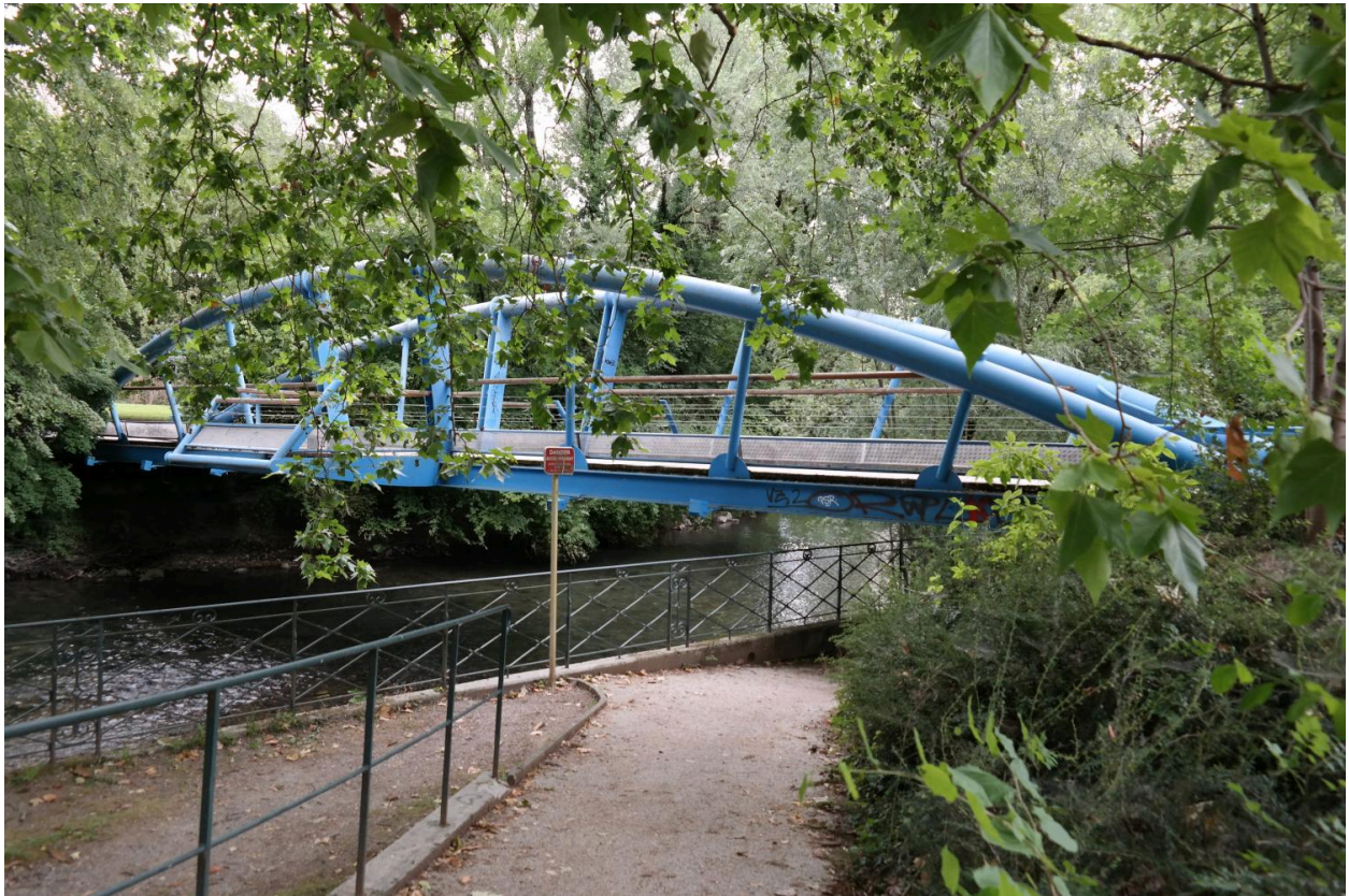
Passerelle piétonne sur le Thiou, vue de la face amont
