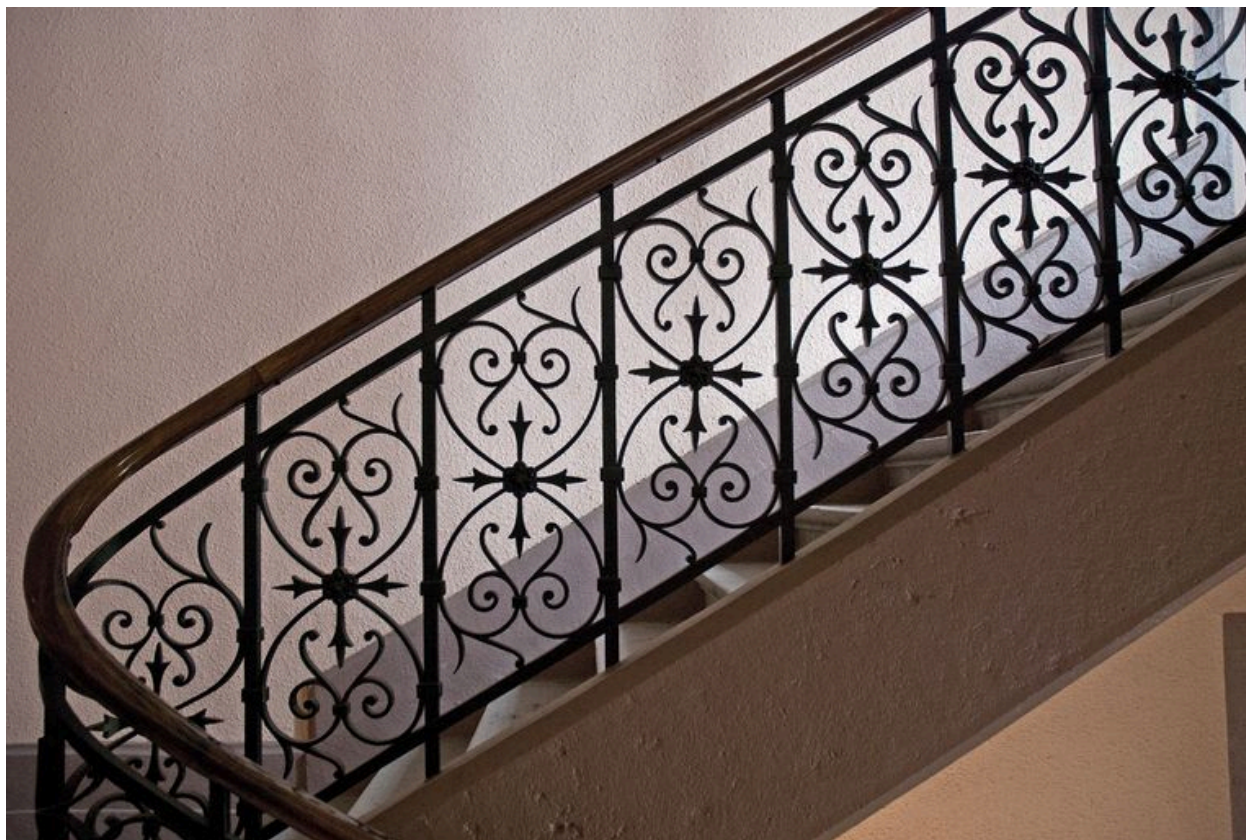
Escalier principal, détail du garde-corps
