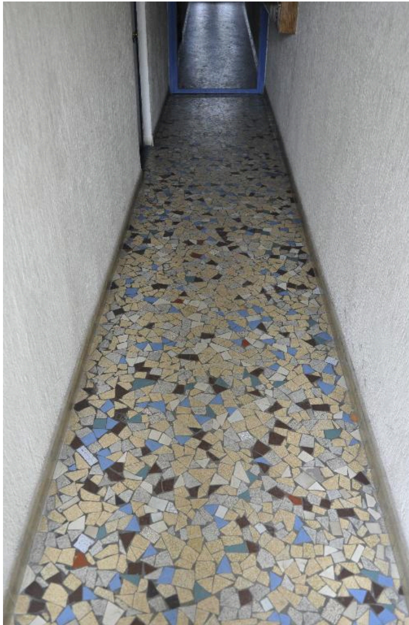
Vue intérieure : pavement de l'allée
