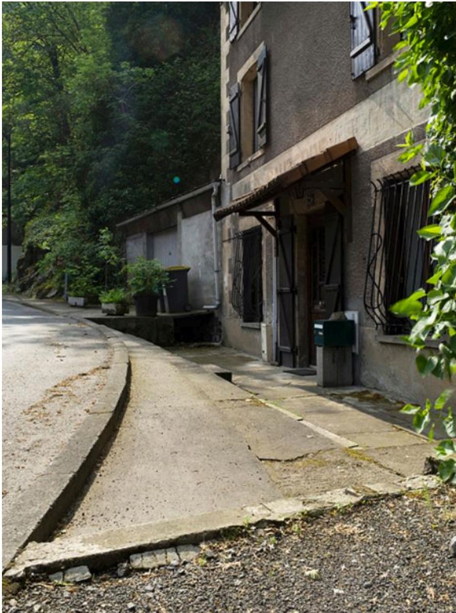
L'avenue Joseph-Claussat et les aménagements de ses abords : trottoir à degrés.
