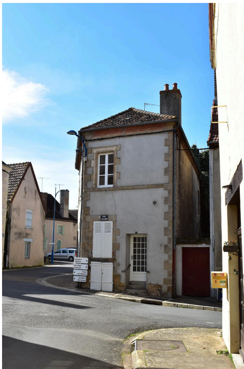
Maison, n°1 angle de la rue d'Allier et de la place Henri Barbusse, parcelle cadastrale B01 : 76. Entrée de cave en sous bassement.
