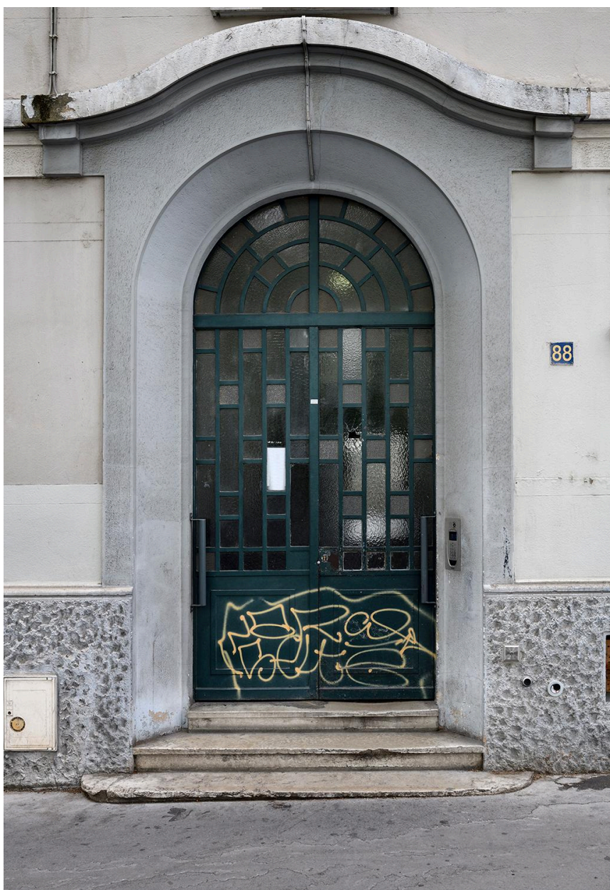
Elévation route de Vienne : la porte
