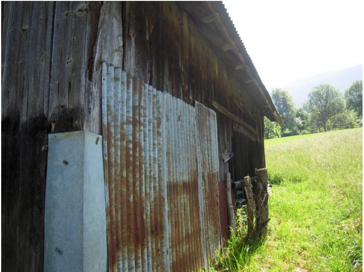
Vue de la façade sud.
