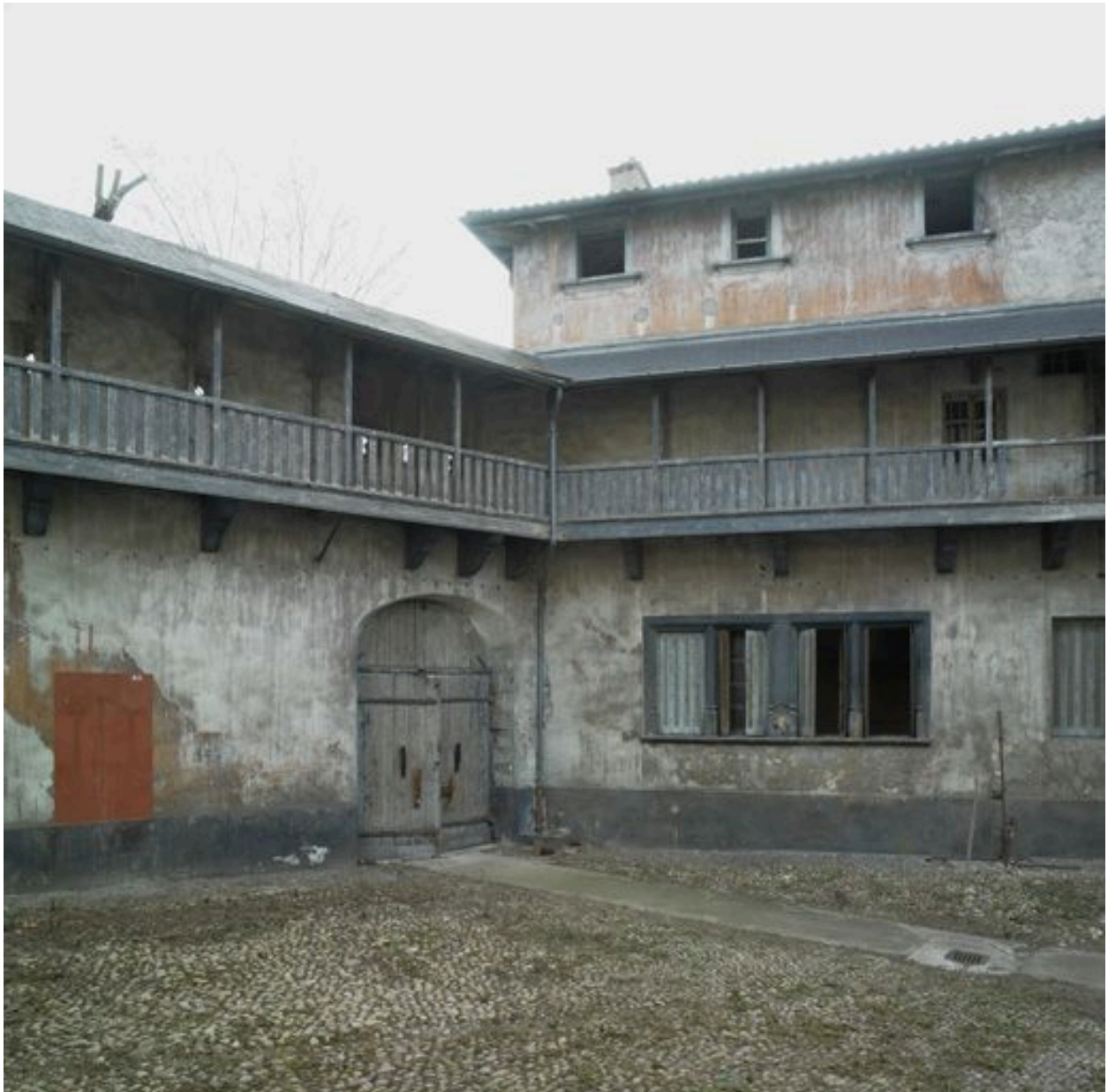
Angle sud-ouest de la cour
