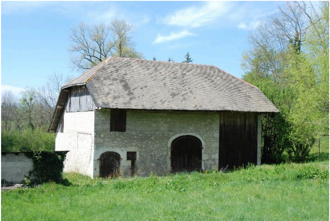
Les Nantets, Grange-étable, parcelle E1 55, élévation de trois-quart avant gauche.
