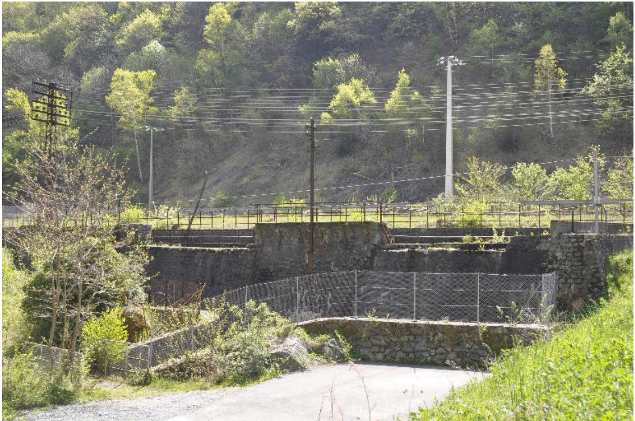
Vue du barrage et de la route
