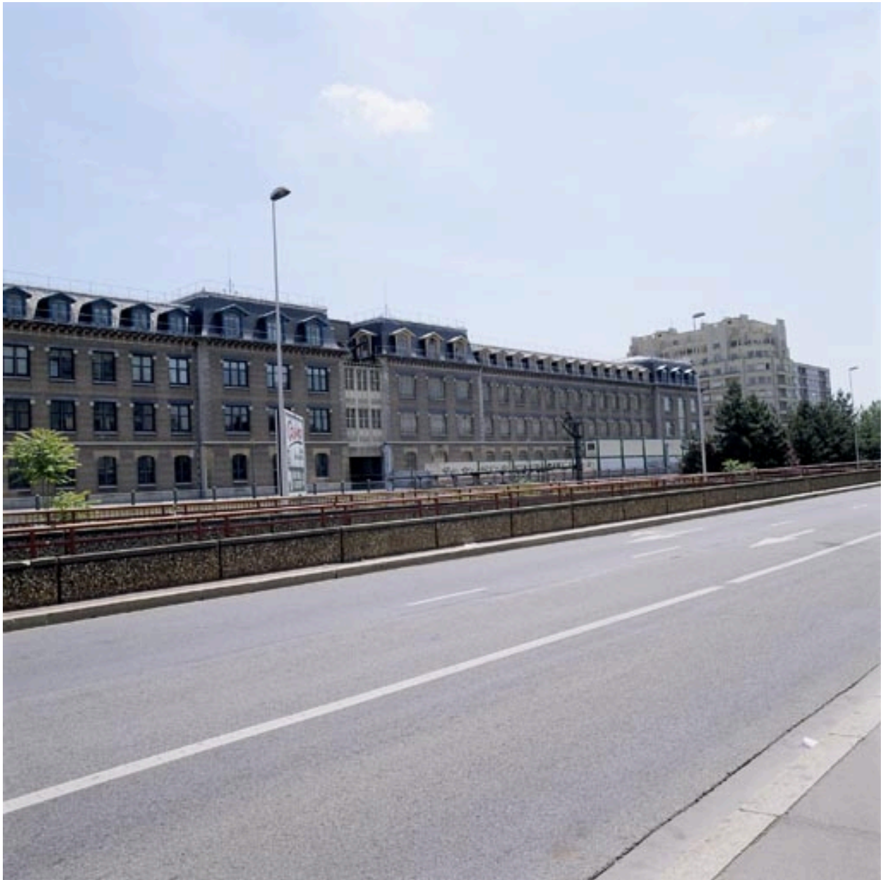
Vue d'ensemble nord
