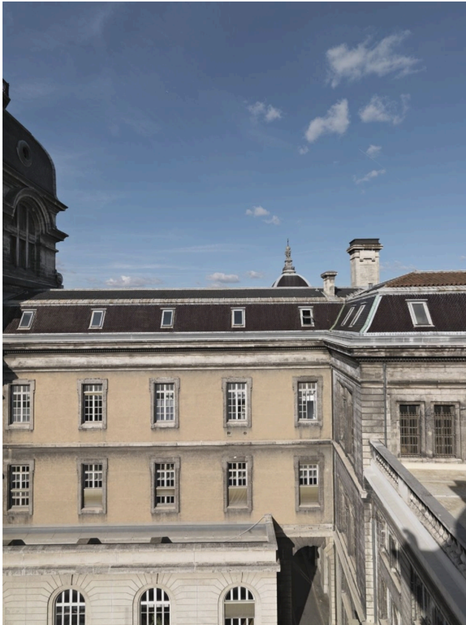
Bâtiment C. Façade sud et accroche du bâtiment A
