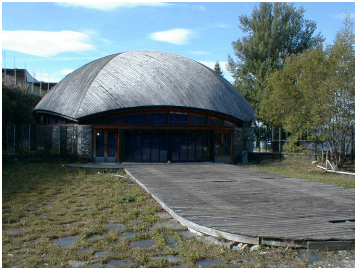
Vue du côté du bassin et de la patinoire
