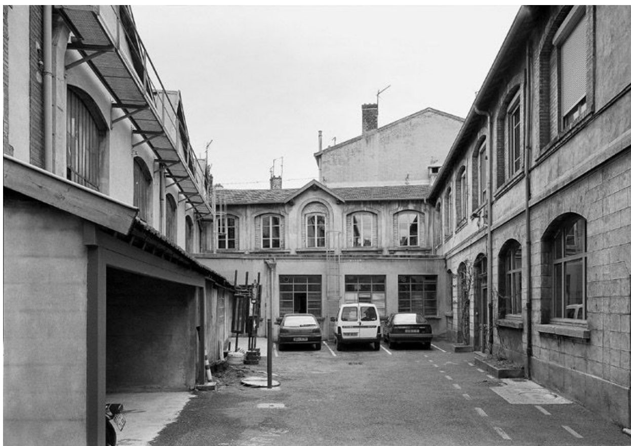
Cour intérieure, vue nord
