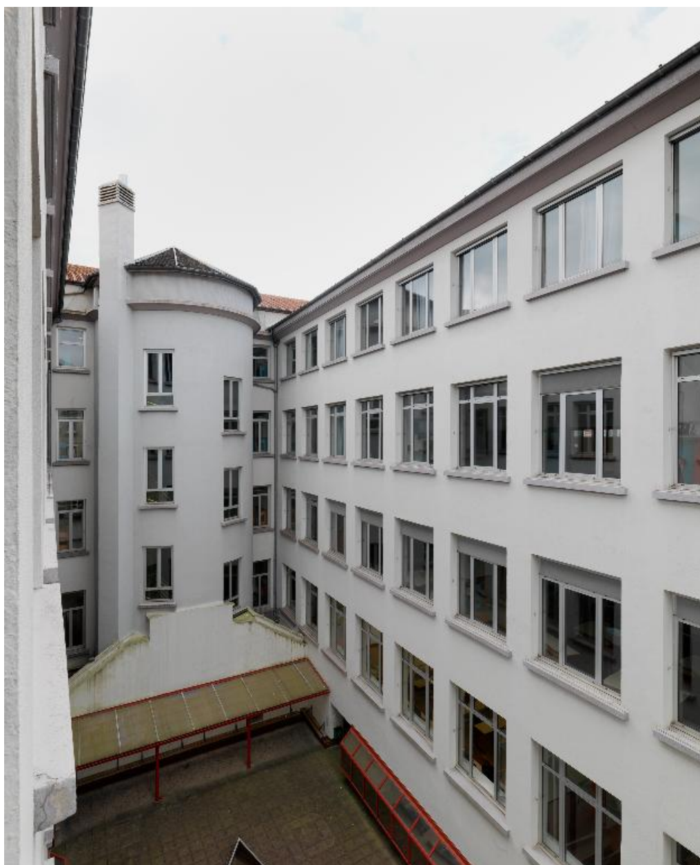
Cour et élévation ouest, depuis le nord
