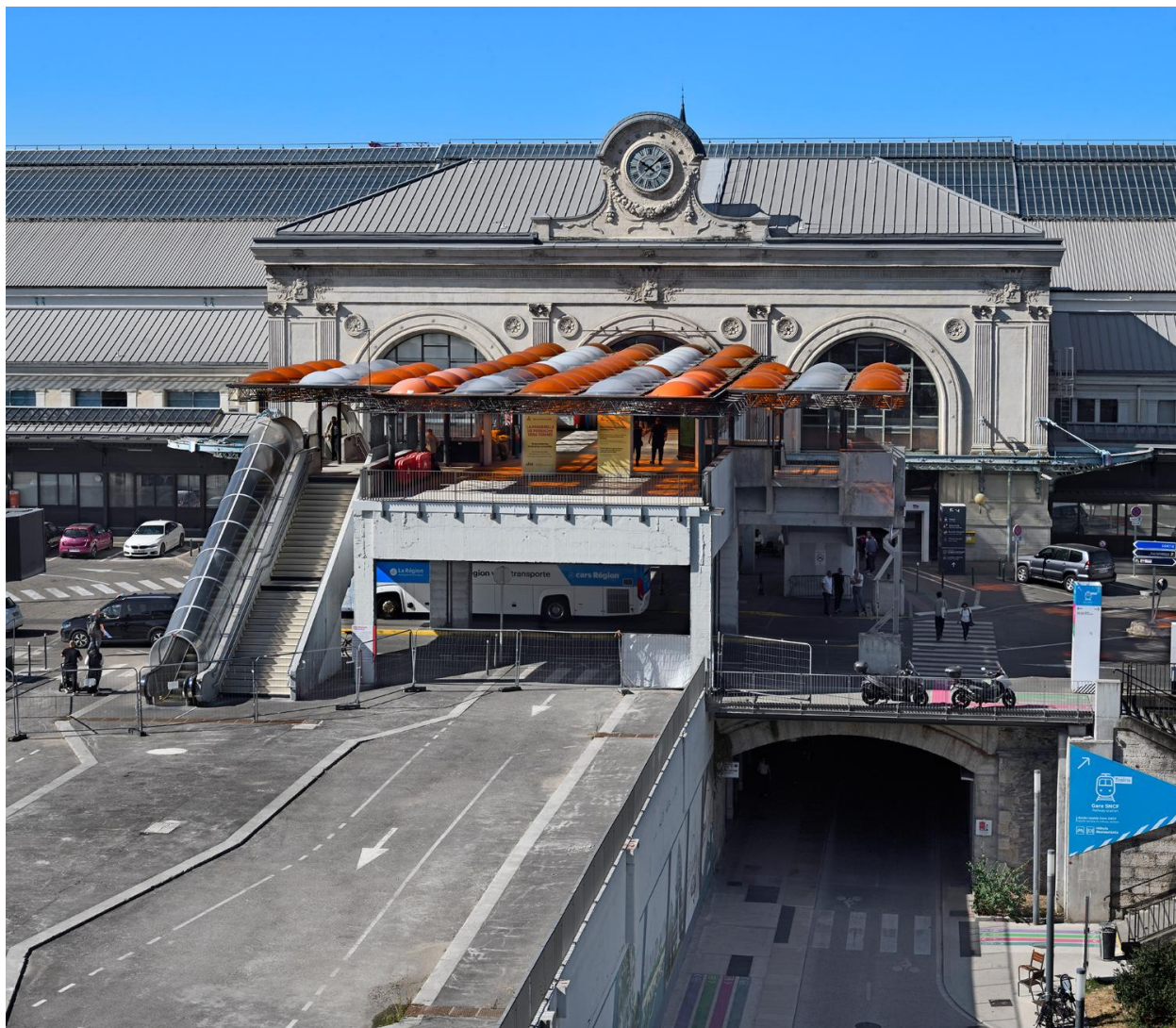
Été 2026 : l'élévation nord du bâtiment voyageurs
