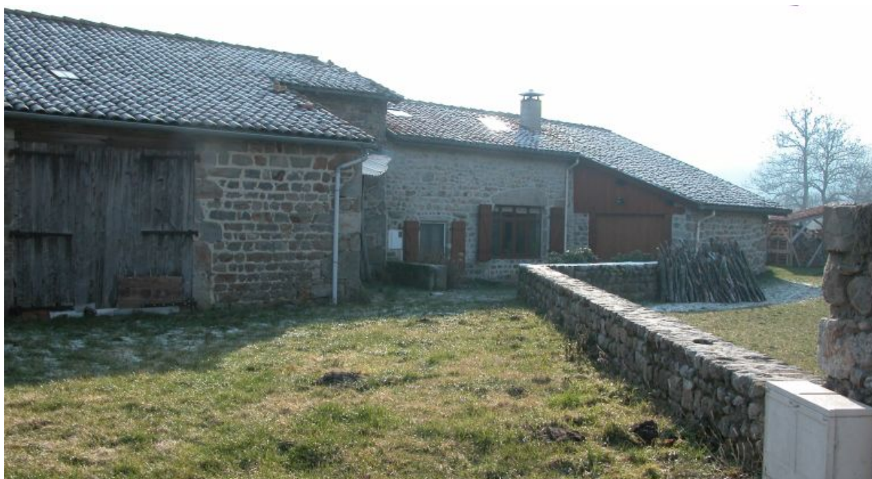
Vue d'ensemble arrière de la ferme.
