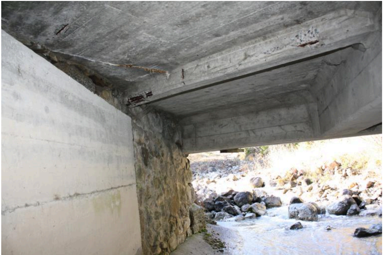
Pont de Crêt, détails pile et tablier
