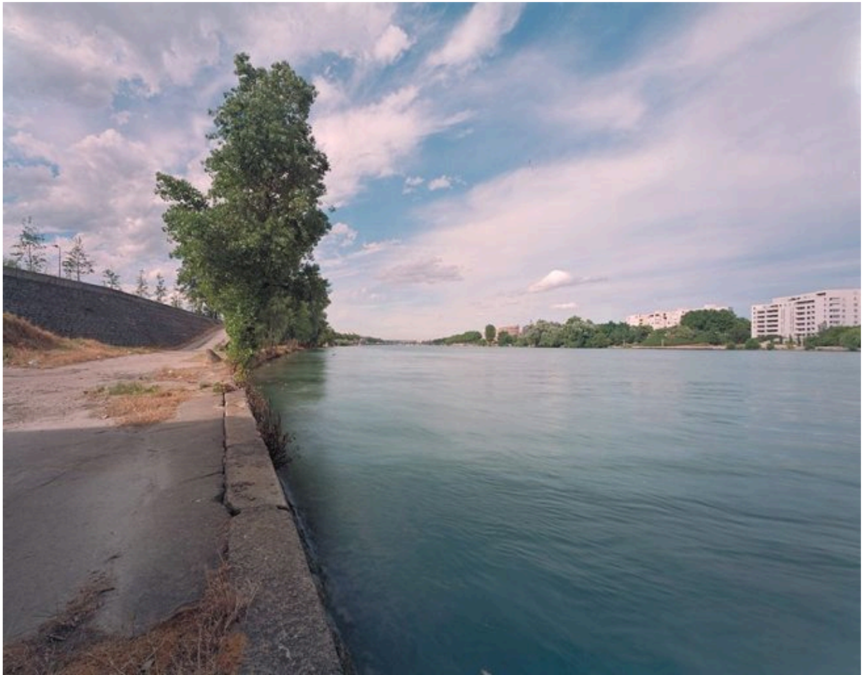
Vue de l'ancienne chaussée Perrache depuis le sud
