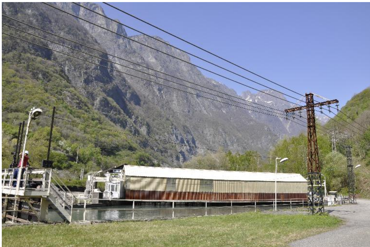
Vue du barrage
