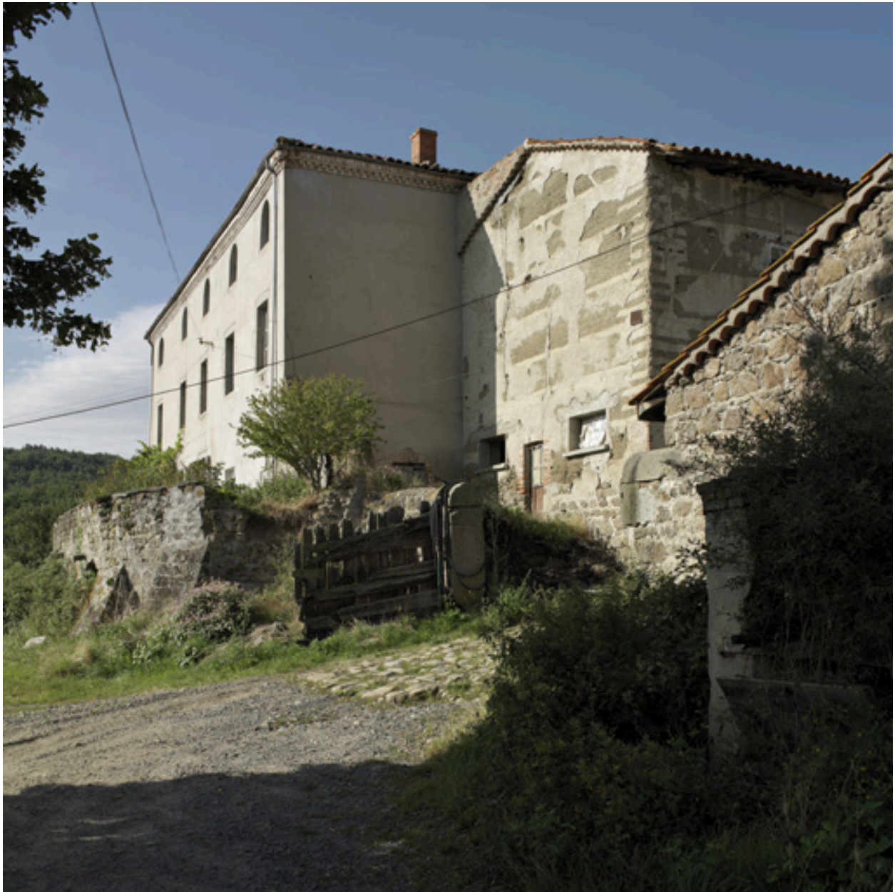
Vue depuis le nord-est (articulation avec la demeure).
