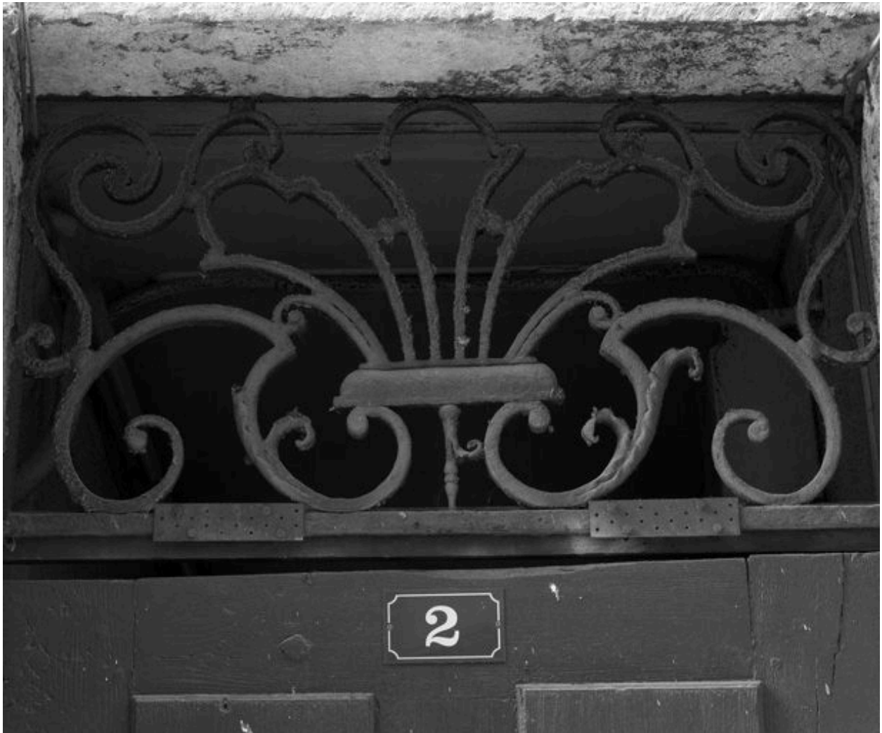
Façade rue Valfenière, porte, détail du tympan de ferronnerie
