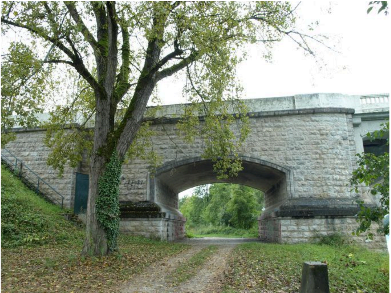
Culée passante, rive gauche
