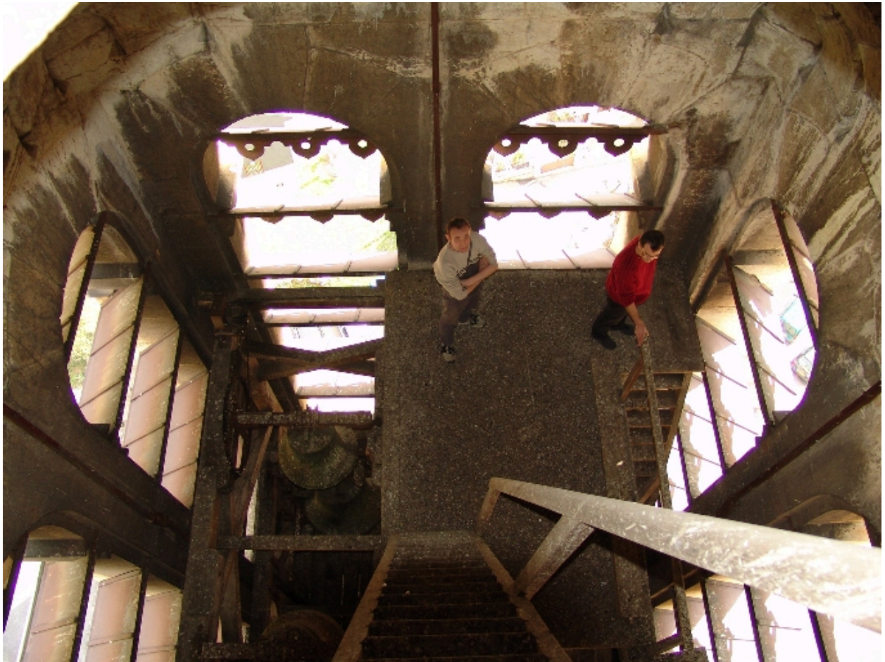
Baies du clocher
