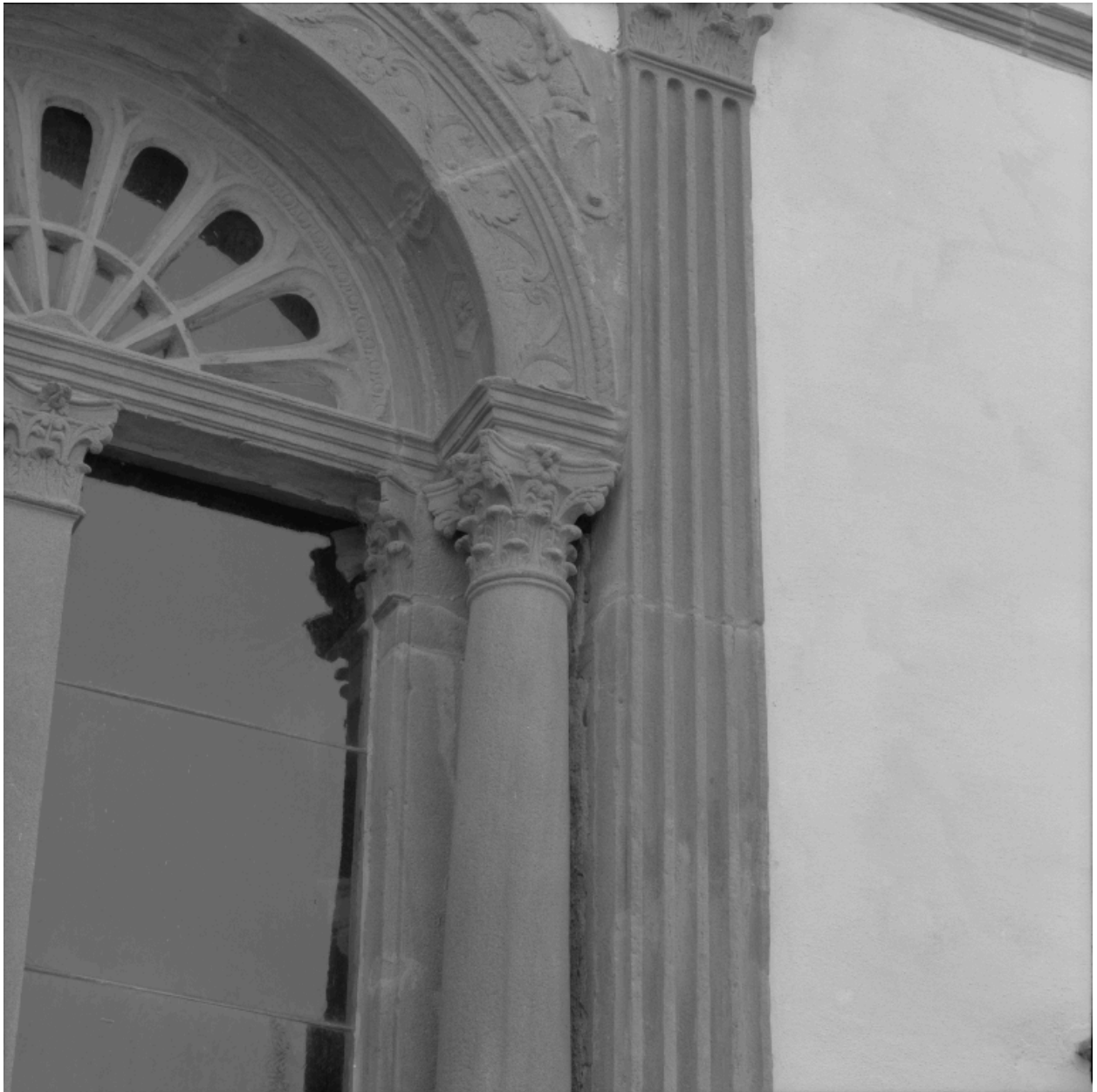
Corps de logis : détail des chapiteaux de la fenêtre de la chapelle.
