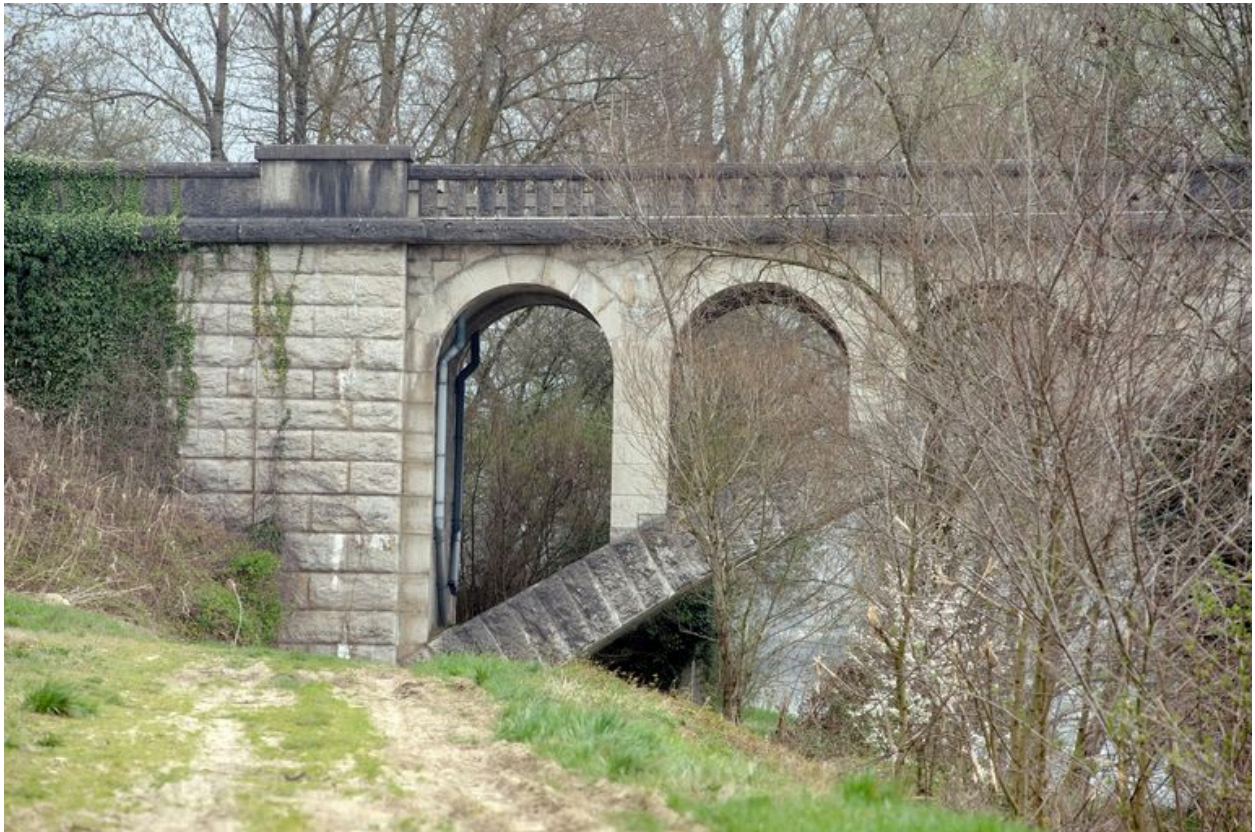
Vue de la culée rive droite, face aval
