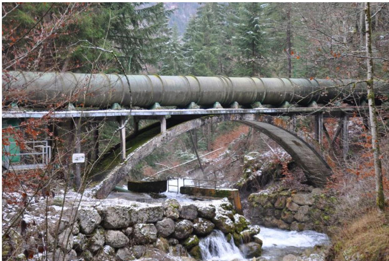
Pont siphon enjambant le nant de la Joux Verte
