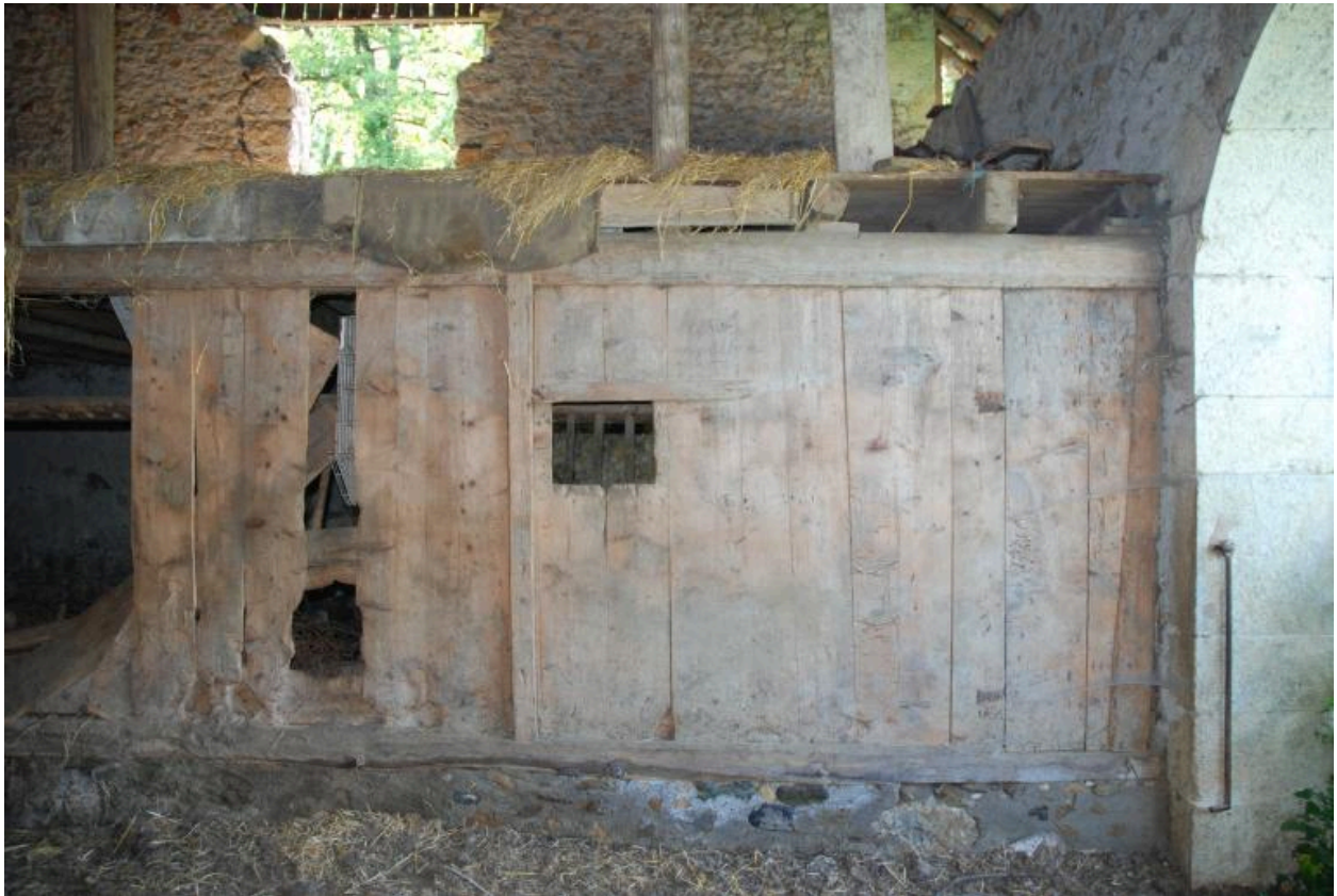
Cloison séparant la grange de l'étable.
