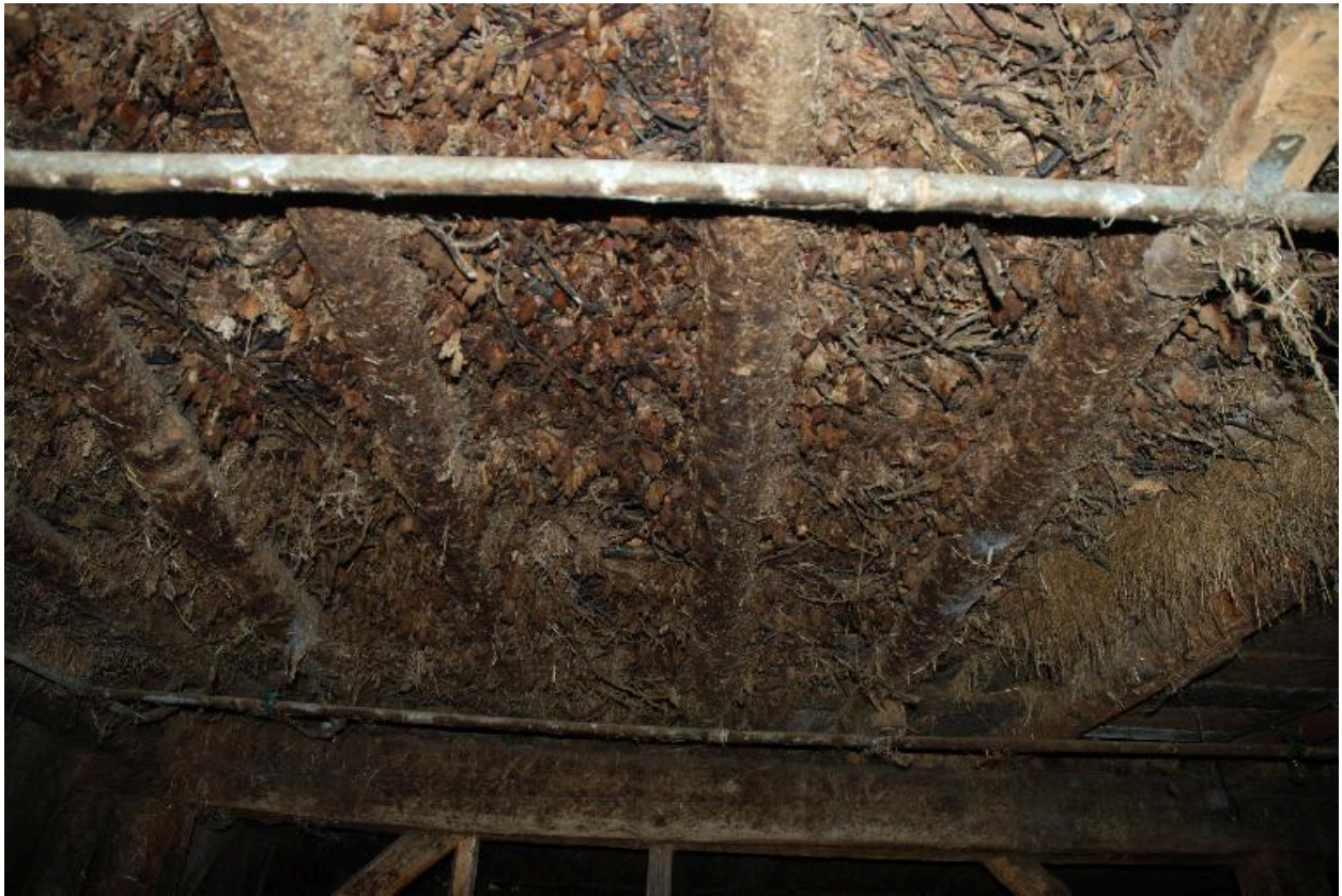
Vue intérieure de l'étable : détail du plafond.
